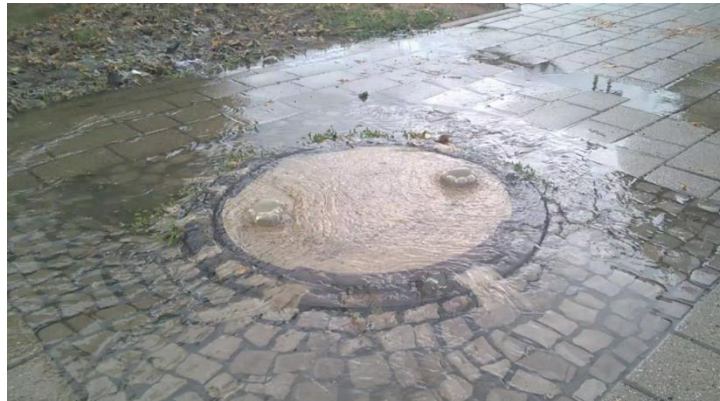
Durch Starkregen verdünntes Schmutzwasser tritt durch die Schachtdeckelöffnungen
