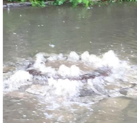
Durch Starkregen verdünntes Schmutzwasser tritt durch die Schachtdeckelöffnungen
