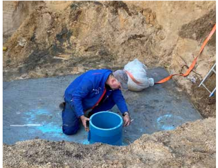
12) Ein Brunnenbauer schneidet das Brunnenrohr zurecht, die in die Brunnenstube führen wird.
