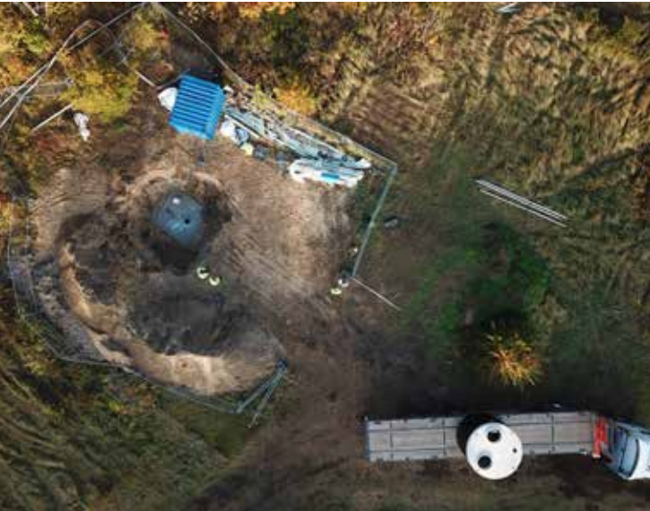
11) Blick von oben auf die Baustelle mitten im Wald. In der Brunnenstube sind alle nötigen Armaturen untergebracht und alarmgesichert.
