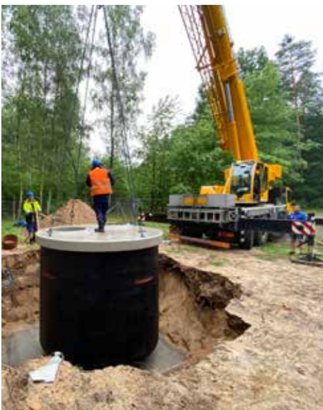
13) Die Betonstube wird mit einem Kran angehoben und in Millimeterarbeit über das Brunnenrohr positioniert.
