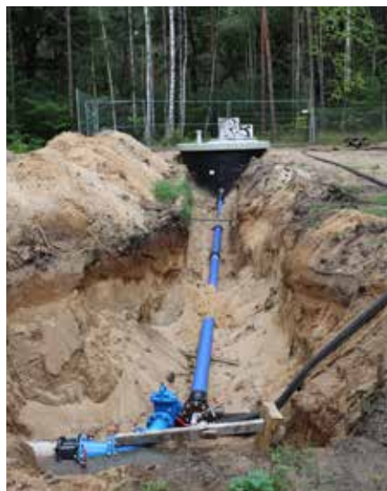
14) Die Brunnenstube ist gesetzt. Über die blaue Wasserleitung ist sie an die Sammelleitung angeschlossen. Von dort wird das Rohwasser zum Wasserwerk transportiert, wo es später aufbereitet wird.
