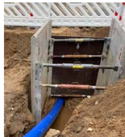
6) Anders als bei der offenen Bauweise können die Versorgungsleitungen DN100 und DN200 verlegt werden, ohne dass dafür lange Strecken aufgedigelt werden müssen. Sie sind flexibel und können so mittels Spülbohrverfahren unterirdisch ins Erdreich eingezogen werden. Die Lebensdauer dieser Kunststoffrohre ist mit mindestens 50 Jahren kalkuliert – bei guten Verhältnissen können es bis zu 100 Jahre werden.
