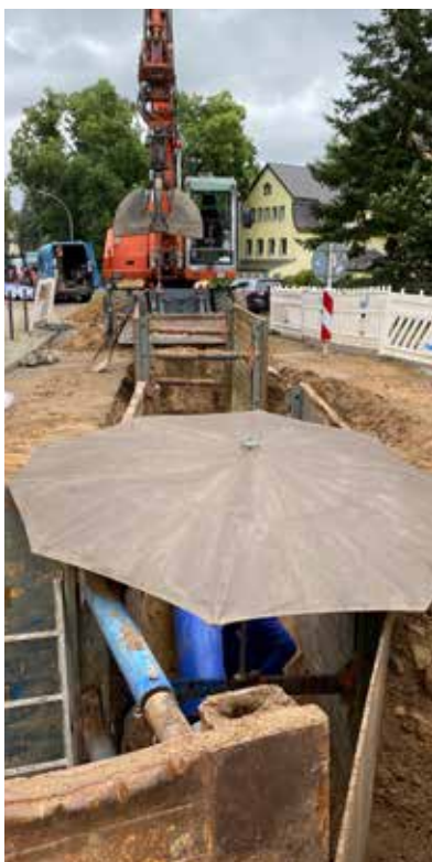
4) An der Ecke zur Bahnhofstraße wird in offener Bauweise gearbeitet und dafür wurde ein Rohrgraben ausgehoben. In einer Tiefe von bis zu 3 Metern wird eine neue Transportleitung DN500 (DN ist der Innendurchmesser mit Angabe in Millimetern) verlegt. Das Rohr muss so tief in der Erde liegen, damit es vor Frost geschützt ist. Die Planung ist kompliziert, denn darüber verlaufen die Gasrohre und eine Reihe von Elektroleitungen, die nicht beschädigt werden dürfen. Nicht immer sind vollständige Bestandspläne vorhanden. Dank Digitalisierung können heute die Lagepläne gespeichert werden und sind damit auch in Zukunft besser verfügbar.
