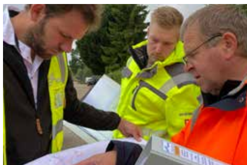
2) Peter Stube, Helmut Keßler und Frank Löhrike, der Bauleiter der Firma Eso Bau, schauen sich gemeinsam noch mal den Verlauf der neuen Leitung auf dem Plan an. Während eines Rundgangs klären sie, wo später Material für die Bauarbeiten gelagert werden kann. Die Ingenieure der Investitionsabteilung sind Projektkoordinatoren und übernehmen damit komplexe Aufgaben. Sie sind als Vertreter des Bauherren ebenso für die Planung wie auch die korrekte technische Ausführung verantwortlich. Dazu gehört die Steuerung der Baufirmen und interne Koordination mit den Bereichen des WSE genauso wie die Kostenüberwachung und Rechnungsprüfung.
