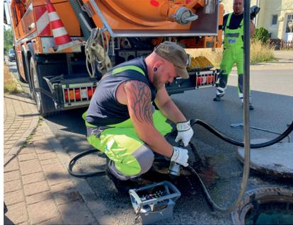
2) In der Brandenburgischen Straße werden neue Häuser gebaut. Bevor der Kran auf der Straße aufgestellt wird, dokumentieren die Kollegen den aktuellen Zustand des Abwasserkanals. Dafür müssen die Rohre zuerst gereinigt werden. Alexander Budde-Härtwig montiert eine rotierende Hochdruckdüse. „Die zieht sich gleich mit rund 110 bar in den Kanal“, erklärt er.
