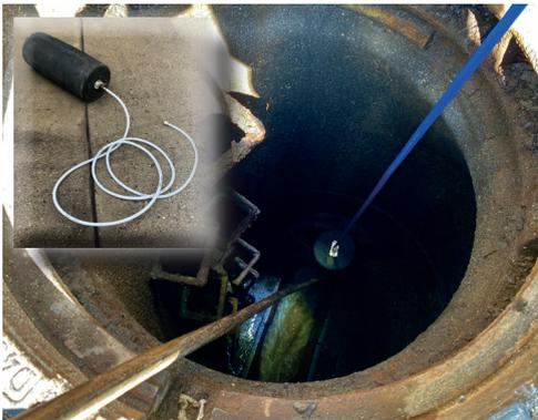
4) Wegen einer Verstopfung musste dreimal gespült werden. Haare, Speisereste und feuchtes Toilettenpapier bilden hin und wieder einen Pfropfen, das Wasser fließt dann über einen Überlauf ab. Doch jetzt ist das Rohr sauber und der Kanal wird für ein paar Minuten verschlossen, damit kein Schmutzwasser nachläuft. Der riesige Stöpsel dafür wird in den Abwasserschacht abgelassen. Er heißt Blase, weil er im Rohr aufgepumpt wird.
