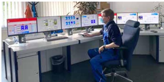
7) Die Leitwarte ist das Herz des vollautomatisierten Systems. Frank Panier (57) überwacht auf den Bildschirmen die Wasserwerke und Druckpunkte. Sensoren melden, wenn etwas nicht stimmt. Gerade ist ein Filter gespült worden und ein Mitarbeiter hat eine Tür geöffnet, deshalb erscheint eine Meldung in Rot. Niemand kann unbemerkt die Anlagen betreten.
