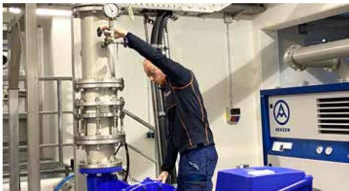
4) In der großen Halle drehen Mario Buß und Thomas Schilling an jeder Armatur und prüfen alle Rohrleitungen. Die gelben Kompressoren in der Halle lärmen. Sie pumpen Luft in das Rohwasser, bevor es über die Filter fließt.
